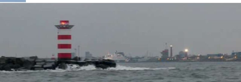
Hafeneinfahrt Ijmuiden mit Ober- und Unterfeuer in der Dämmerung
